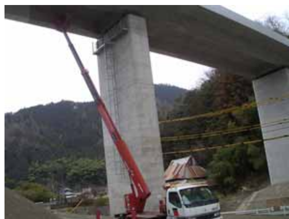
写真4 . PC コンクリート橋床面の調査
