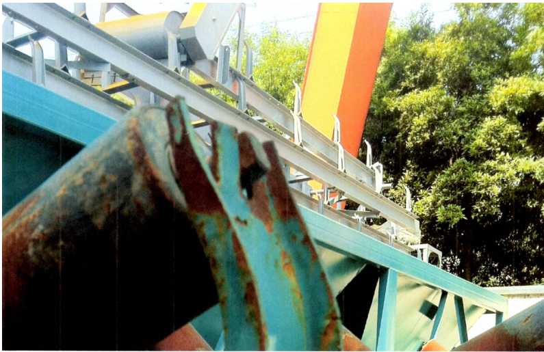
写真 1 . 中国建機の塗料の剥がれ状況
