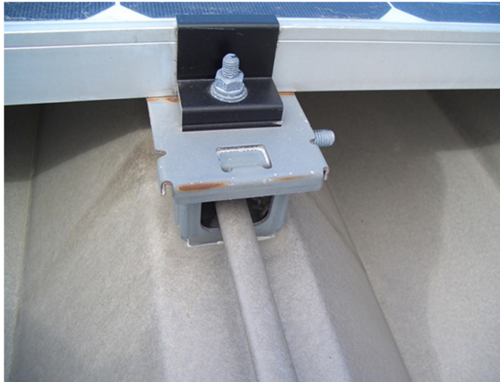
写真1 ソーラーパネルにさび発生
